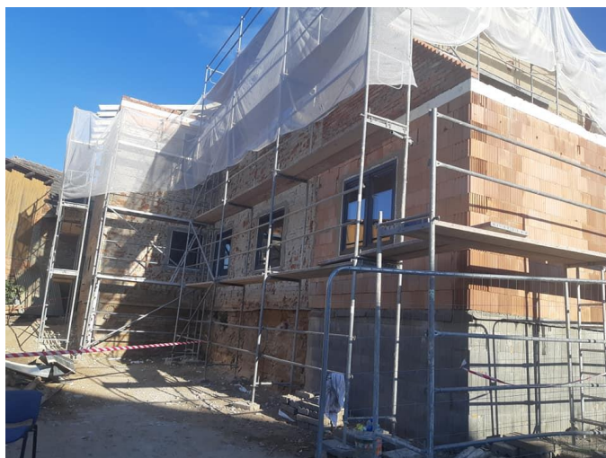
Rekonstrukce bývalé obecní školy v Nětčicích.
