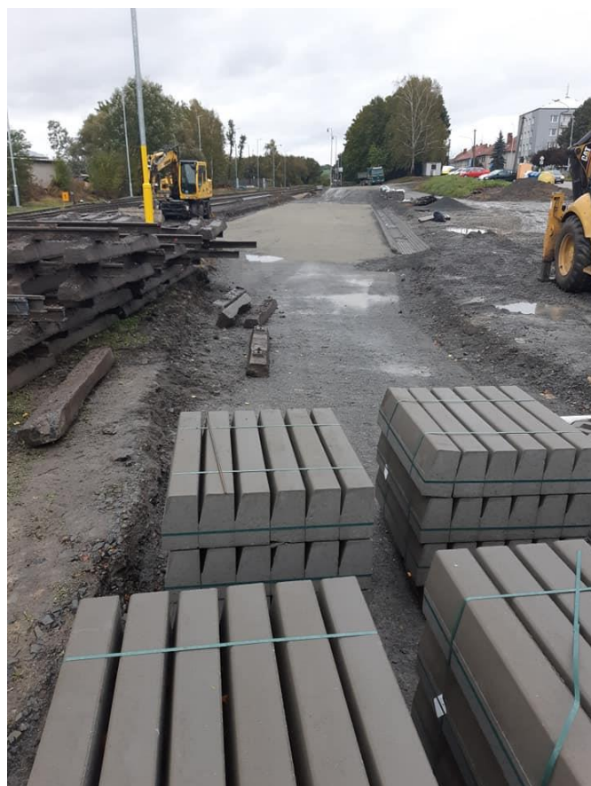
Nové „náklaďště“ vedle nádraží pro osobní železniční dopravu včetně kompletní výměny celé první koleje.
