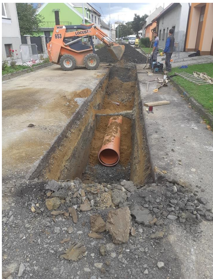
Výstavba nové kanalizace v Tyršově ulici ve Zdoučkách v rámci celého dotačního projektu „Zdounky - dostavba kanalizace včetně místních částí - I. etapa“. Zaměstnanci firmy ČAK CZ, s.r.o.
